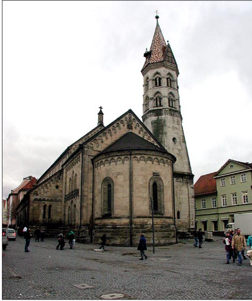
Joonis 1. Schwäbisch Gmündi Johannese kirik. See hilisromantismi sakraalarhitektuuri kaunis näide on ehitatud aastatel 1220–1250 kolmelöövilise sammubasiilikana varem samal kohal asunud kiriku vundamendijäänustele. Pikihoone kõrval kõrguv torn on Švaabimaa kauneimaid ( www.public.iastate.edu/~kmloney/FIL/Chapters/newYear/gmund/square.jpg ).
